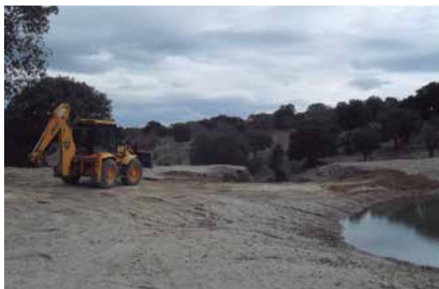
Maquinaria realizando trabajos de excavación.
