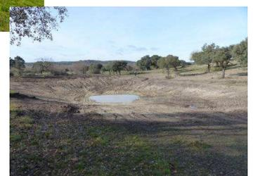
capa de suelo vegetal original, e impermeabilizar el interior de la nueva charca con la maquinaria, utilizando arcilla natural de fondo. Estas charcas se vallaran, total o parcialmente, para que la presión no sea excesiva y así no dañar las posteriores actuaciones de revegetación con especies típicas de ribera.
