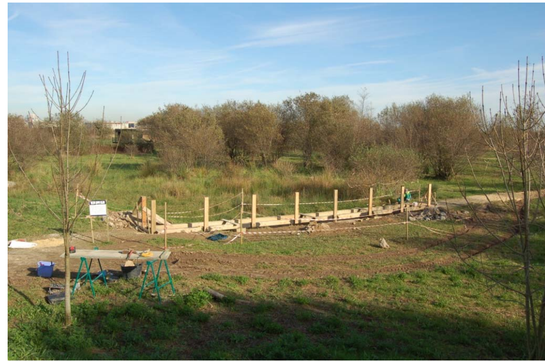
Construcción de pasarela sobreelevada por miembros de la FNYH en la laguna dulce de las Marismas de Alday.
