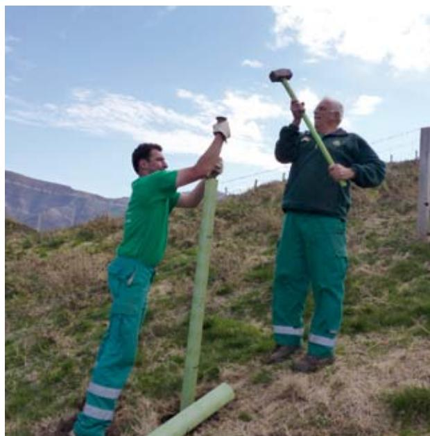
Los tubos protectores se colocan con varillas de hierro que actúan como tutores resistentes al viento y a las nevadas.
