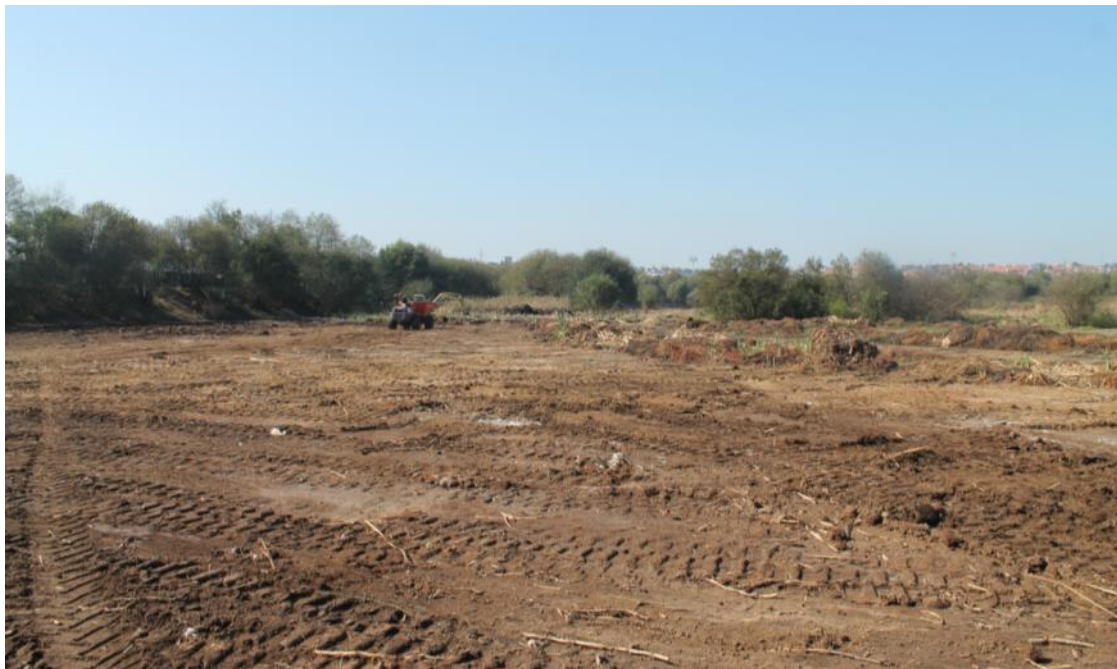
Extracción mediante dumper para acopio en zona accesible para camiones dumper.
