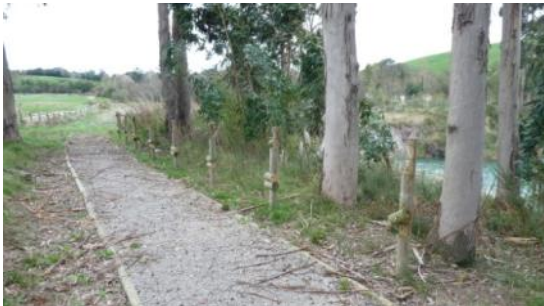
Aspecto previo a la reparación en el Pozón de la Yesera
