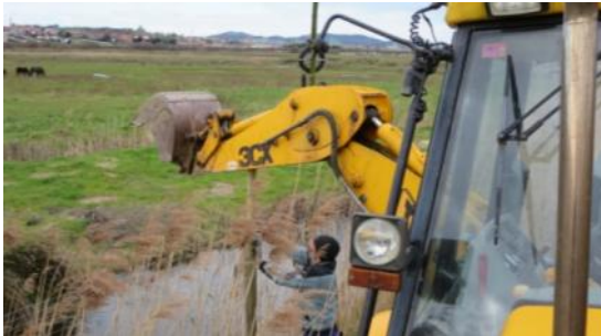
Colocación de nuevas estacas para refuerzo de cierre perimetral en Alday
