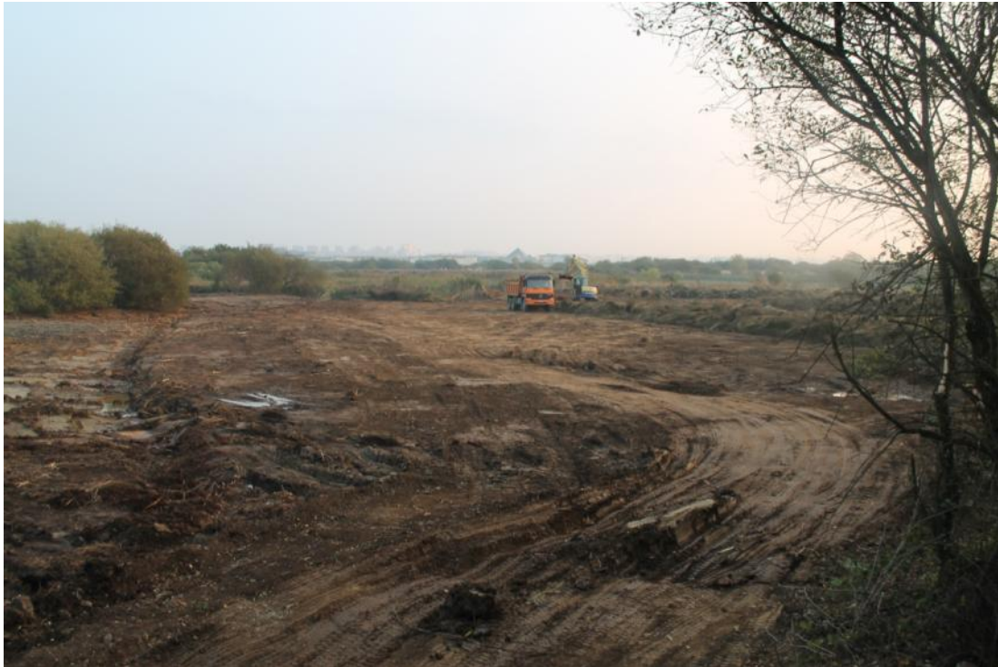
Llenado de camiones para transporte a vertedero
