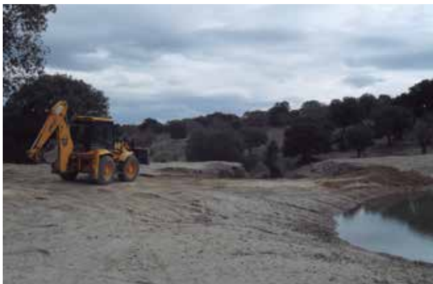
Maquinaria realizando trabajos de excavación.
